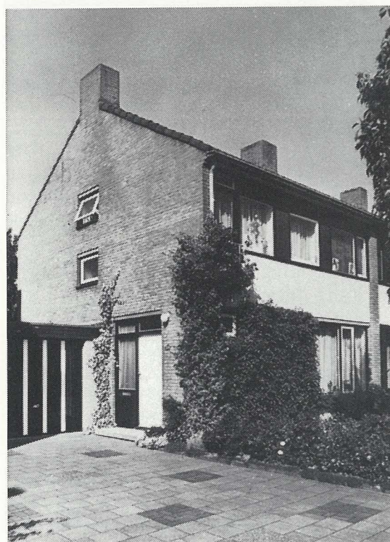
Pand Voldersdreef 38 Maastricht, bouwjaar 1964.
